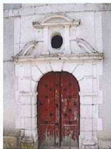
Porte de l'ancienne poste
